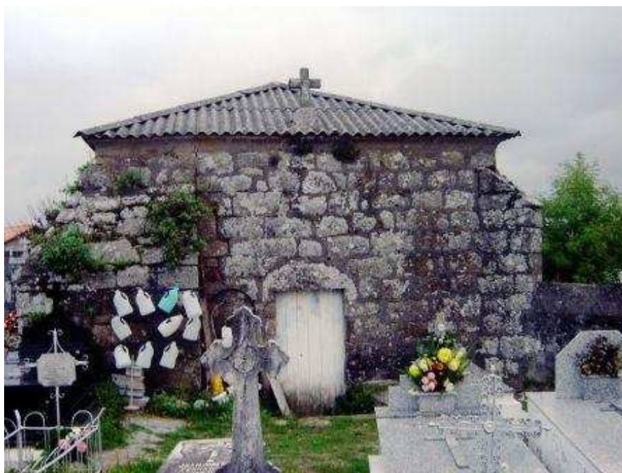
Capilla de los Serantes. Vista exterior. Foto Lamigueiro 2005.
